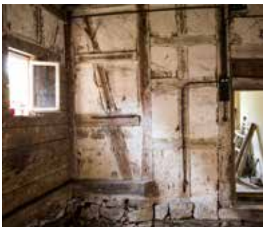
Die Tapete von damals hängt in Fetzen von der Wand, das Gebälk ist morsch und baufällig – doch bei genauerem Hinsehen lauert unter dem Putz ein historischer Schatz
